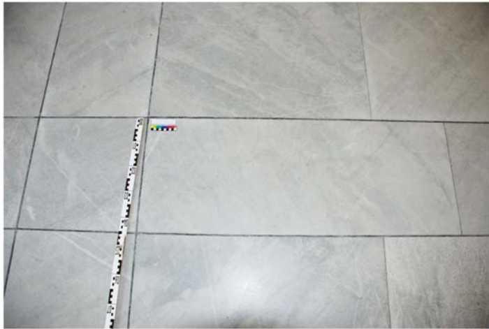
Abb. Ma 14 Sitzungstrakt; Fußboden Raum 120: Rastermaße der Platten 880 mm und 450 mm, Fugenbreite 9mm und 2mm, Verfügung Zementmörtel
