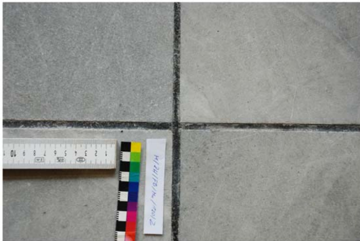
Abb. Ma 15 Sitzungstrakt; Fußboden Raum 120: Verfügung 9 mm als Gestaltungsmerkmal
