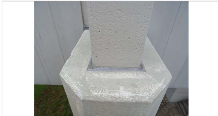
Foto 9: Aufsicht Balkenkopf mit Durchführung der Hängesäulen
