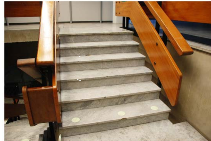
Abb. Ma 24 Zentralgebäude; Treppe: Tritt- und Setzstufen aus Marmor
