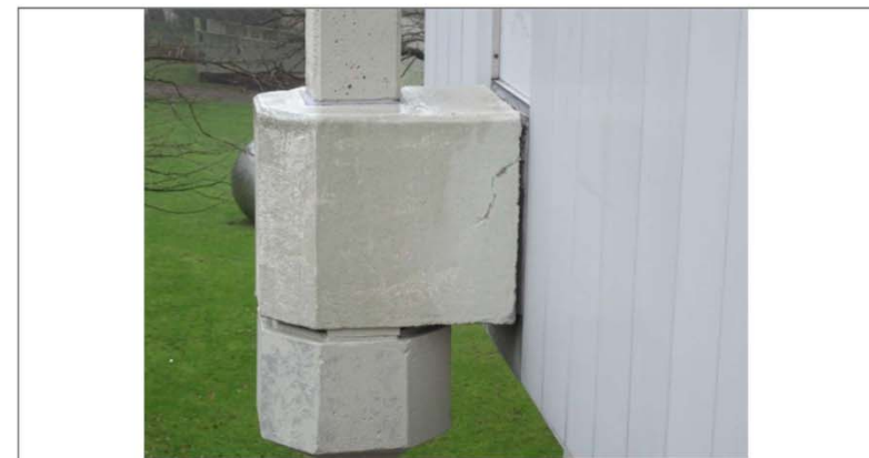
Foto 8: Riss in der Beschichtung an einem Balkenkopf, Bereich konnte nicht handnah befahren werden
