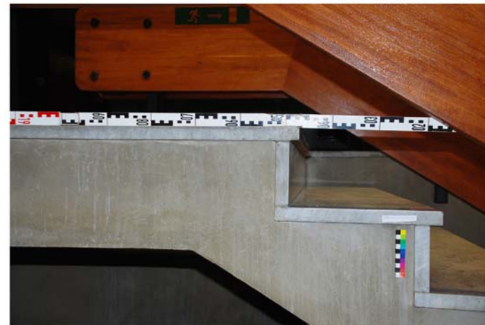
Abb. Ma 25 Zentralgebäude; Treppe: Tritt- und Setzstufen aus Marmor
